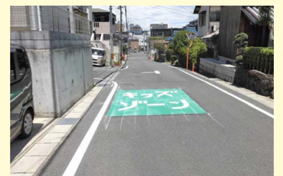
キッズ・ゾーン路面標示
