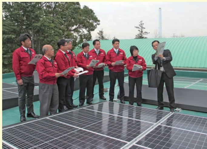
花見川区積橋中学校・太陽光発電設備
